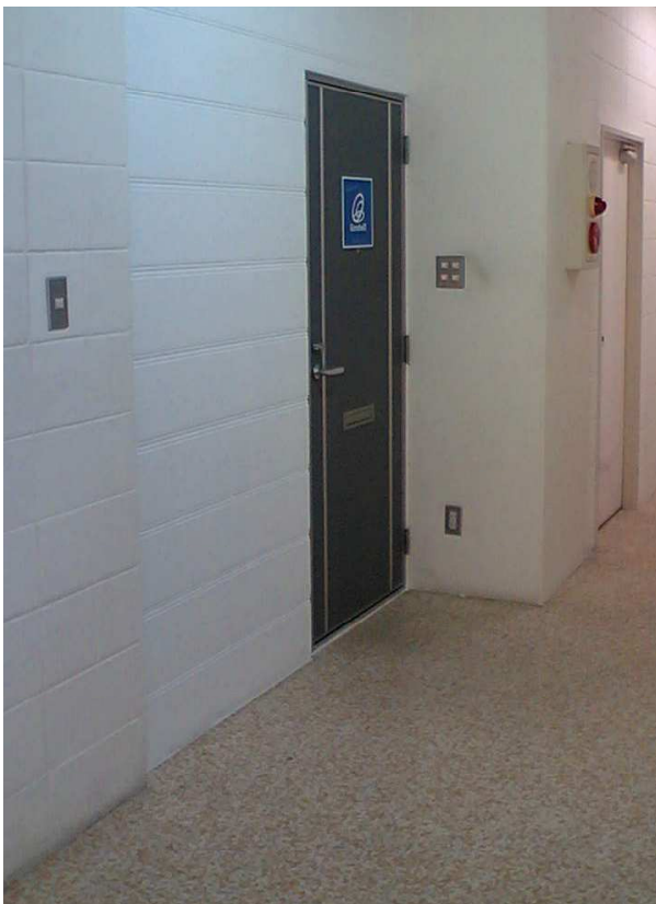
オフィスビルのドア取替工事（完了）
