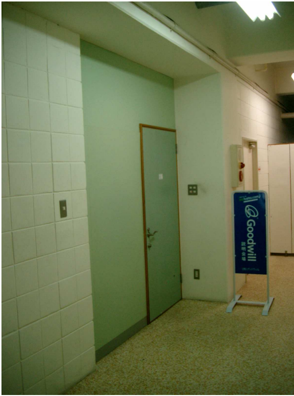
オフィスビルのドア取替（工事前）
