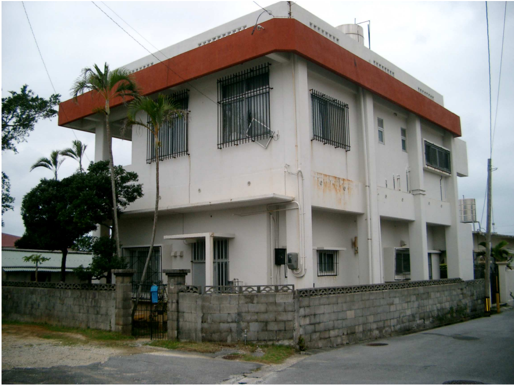
S 邸防水・塗装施工前
