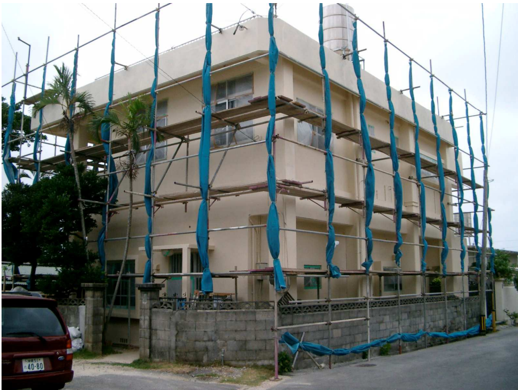
S 邸防水・塗装施工中
