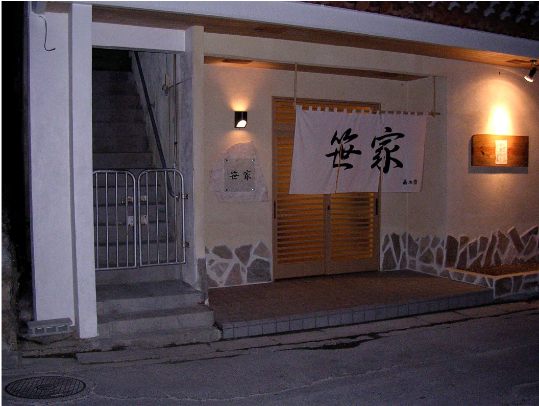
店舗外観（外壁は琉球漆喰の塗り壁）
